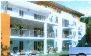
Der „Prinzregentenpark“ in Rosenheim ist das aktuelle Bauprojekt der „D&S“
